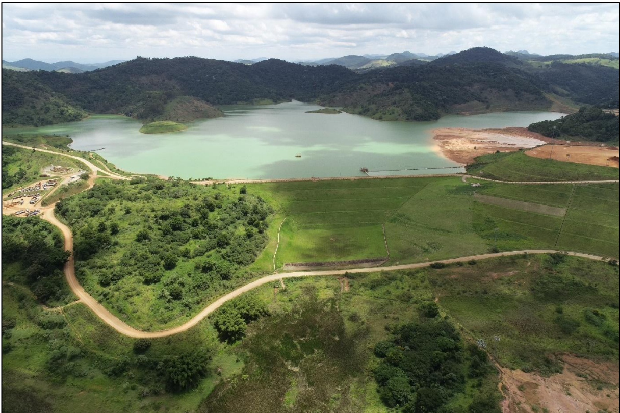
Figura 2-2 – Vista geral da Barragem Mirai – Maciço Principal. Fonte: CBA, 2020.
