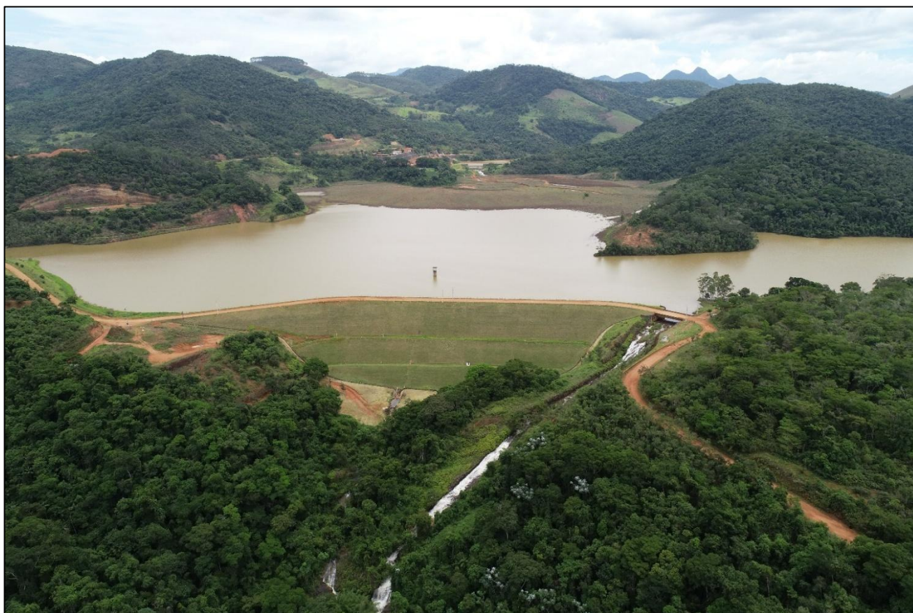
Figura 2.2 - Barragem de Rejeitos Itamarati de Minas. Fonte: CBA, 2022.
