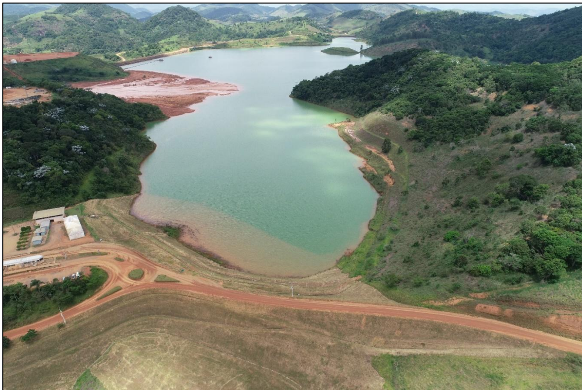
Figura 3-3 – Vista do Dique 1. Fonte: CBA, 2022.
