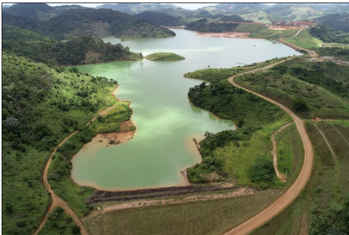
Figura 3-4 – Vista do Dique 2. Fonte: CBA, 2022.
