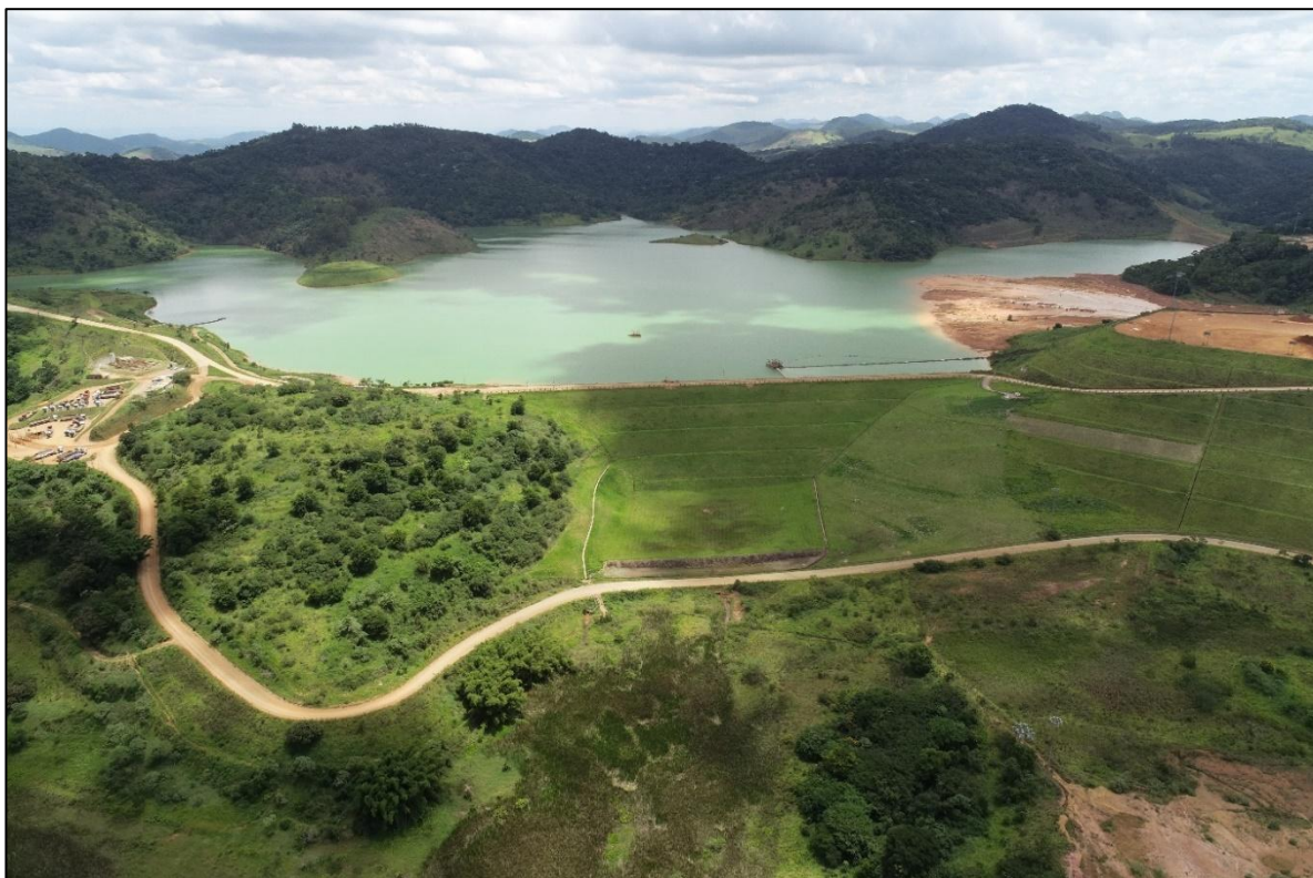
Figura 3-2 – Vista geral da Barragem de Mirai – Maciço Principal. Fonte: CBA,2022.
