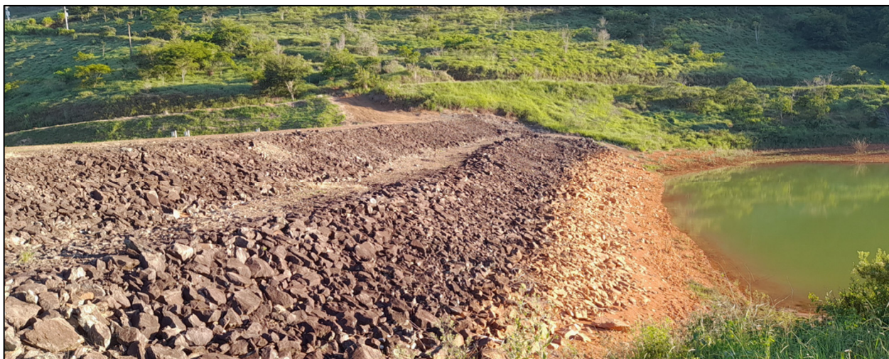
Figura 2-4 – Vista do Dique 2. Fonte: HIDROBR, 2024.
