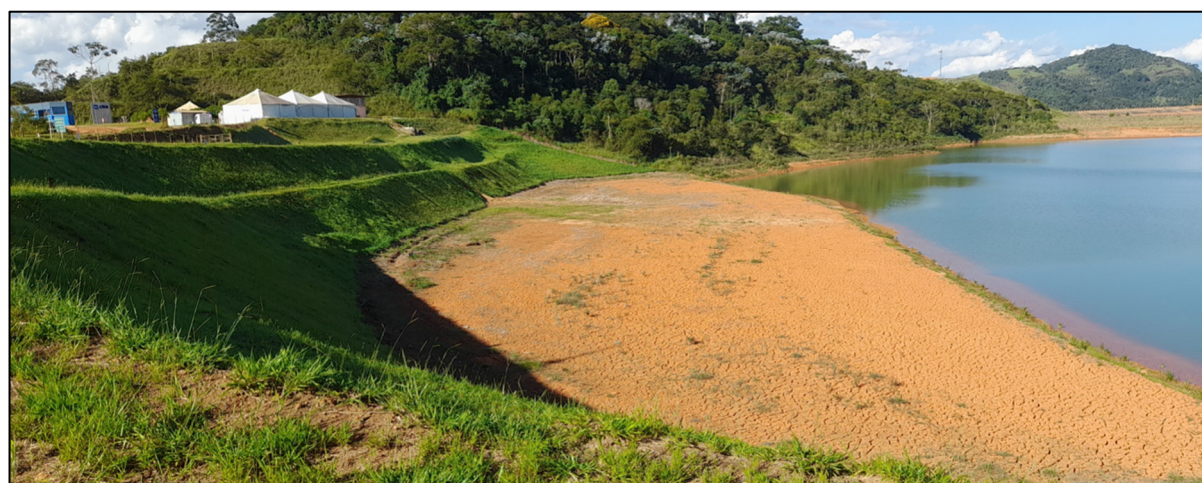
Figura 2-3 – Vista do Dique 1. Fonte: HIDROBR, 2024.
