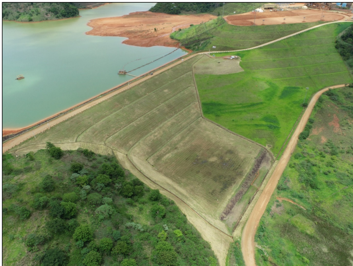
Figura 2-2 – Vista geral da Barragem de Rejeitos Mirai – Maciço Principal. Fonte: CBA, 2024.
