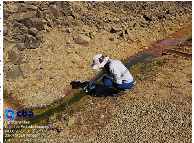
Figura 15: Registro fotográfico do ponto dreno de pé esquerdo, no mês de agosto/2025.
