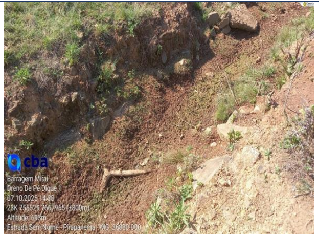
Figura 23: Registro fotográfico do ponto dique 1, no mês de outubro/2025.
