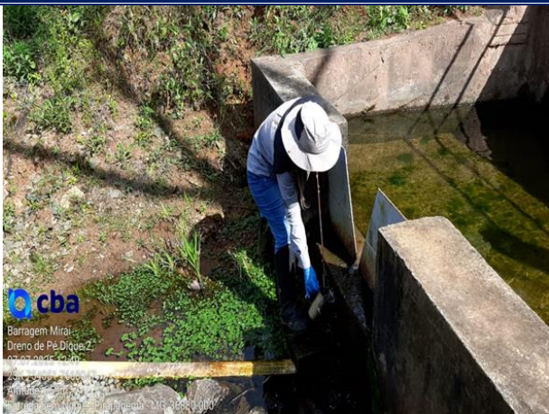
Figura 24: Registro fotográfico do ponto dique 2, no mês de julho/2025.
