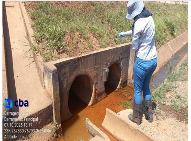
Figura 21: Registro fotográfico do ponto dreno de pé barramento principal, no mês de outubro/2025.
