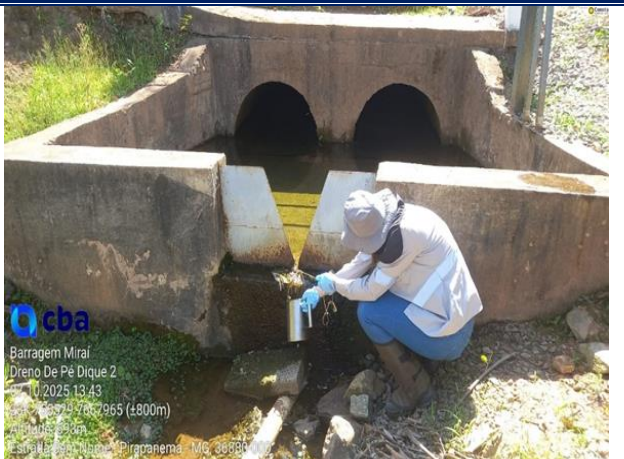
Figura 25: Registro fotográfico do ponto dique 2, no mês de outubro/2025.
