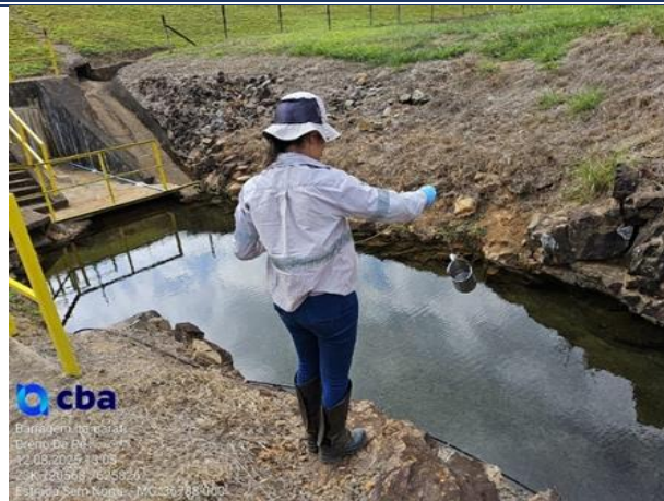
Figura 9: Registro fotográfico do ponto Dreno de Pé Barragem rejeito – Agosto/2025.
