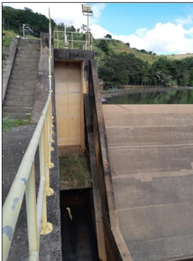
Figura 16. Vista de jusante do Descarregador de Fundo da UHE Sobragi.
