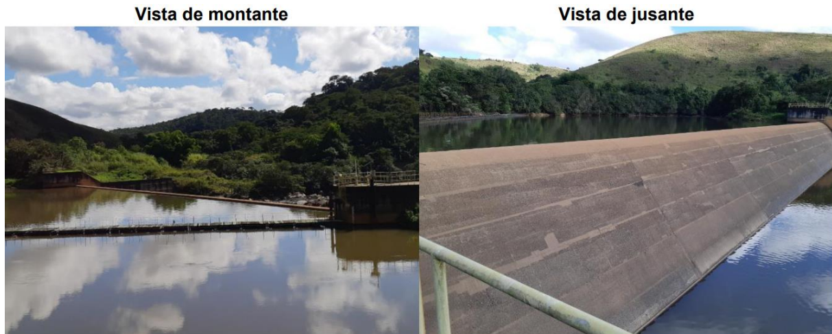
Figura 11. Vistas de montante de jusante do vertedouro de Soleira Livre da UHE Sobragi.
